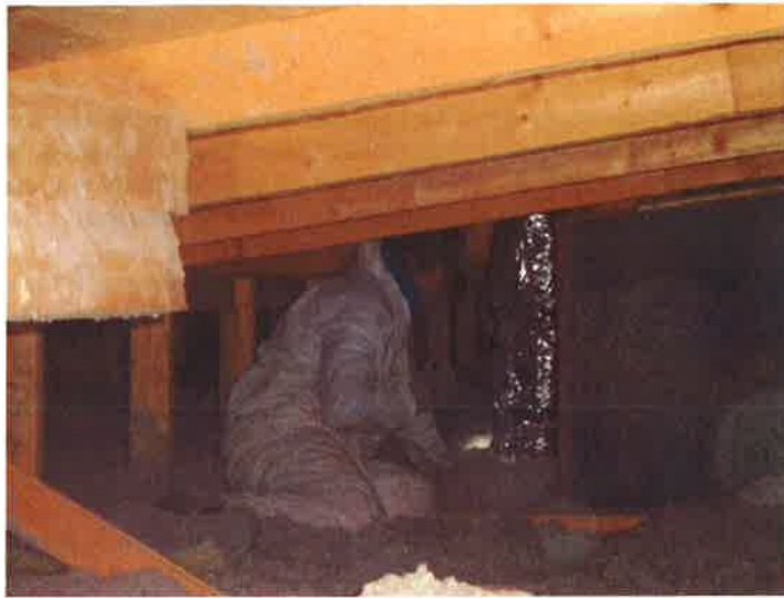
Anttolan yhtenäiskoulun yläpohjan tarkastelu käynnissä
