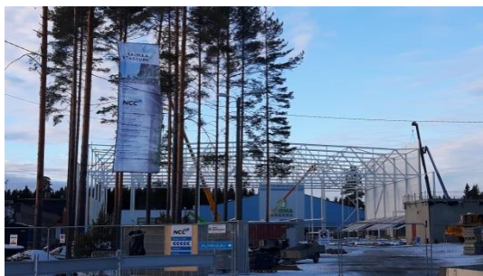
Mikkelin Stadium työmaa helmikuussa 2017
