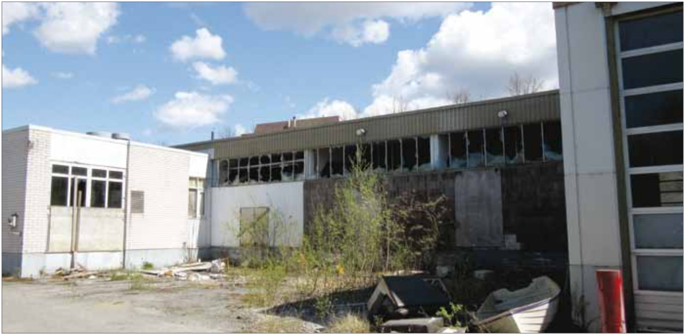
Tarkastuslautakunta kiinnittää huomiota siihen, että kaupungille on kertynyt runsaasti korjausvelkaa. Kuva Rokkalassa olevasta vanhasta meijerikiinteistöstä.
