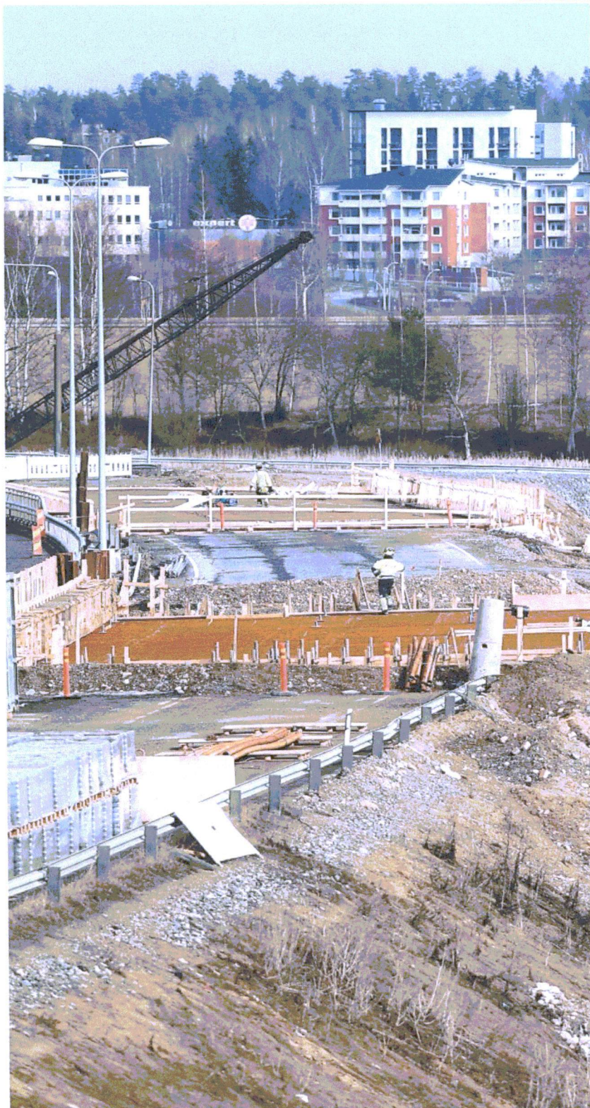
Tietä rakennetaan paraikaa Mikkelin kohdalla neljän kilometrin osuudella. Seuraavat urakat odottavat 37 kilometrin matkalla kohti Juvaa.
